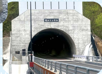
▲奇跡の冠山トンネル、ここに開口!!
